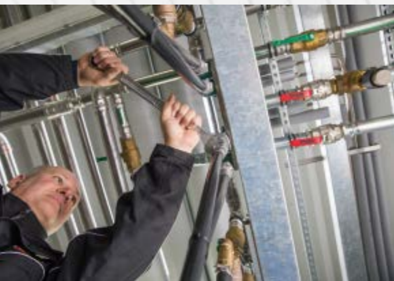
» Die Montage erledigen die Mitarbeiter von Mr. Wash in Eigenregie. » Mr. Wash's own employees perform the installation at the car wash sites.
