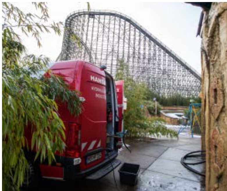
Nach jeder Wartung werden zahlreiche Leerfahrten sowie Probefahrten mit Gewichtsdummies durchgeführt.
